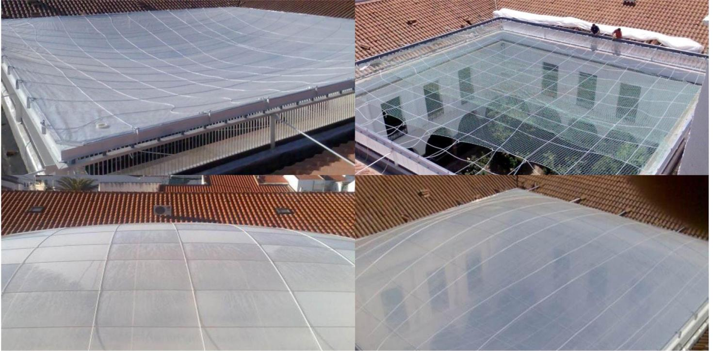
membrana de ETFE (Colchón neumático 15x15 cm sobre ETFE 250 micras con malla de cable)
